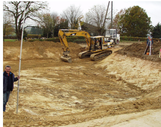
Nivellement eines Rückhaltebeckens im Jahr 2005
