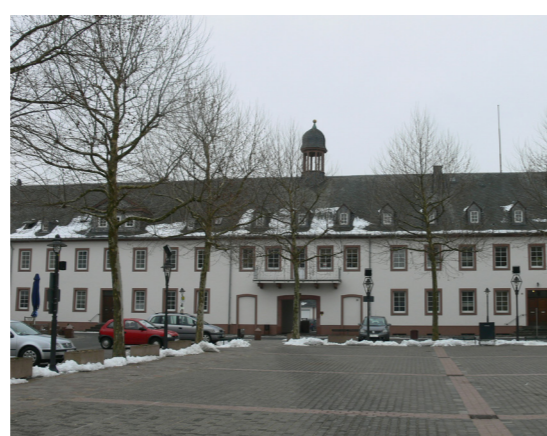
Ansicht Dienstgebäude aus nördlicher Richtung (Stand 2007)
