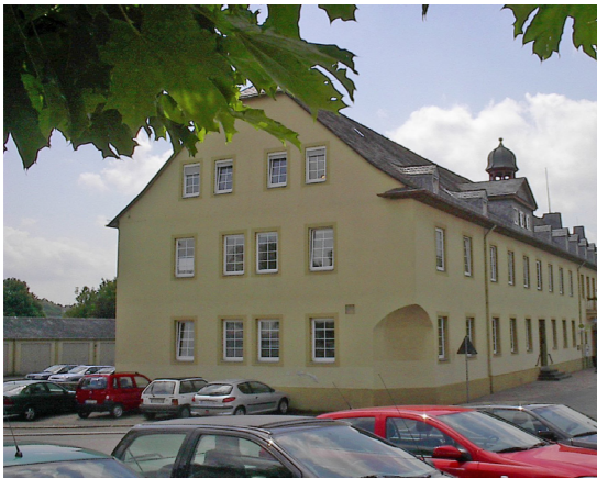
Ansicht Dienstgebäude Simmern aus östlicher Richtung (Stand 2020)
