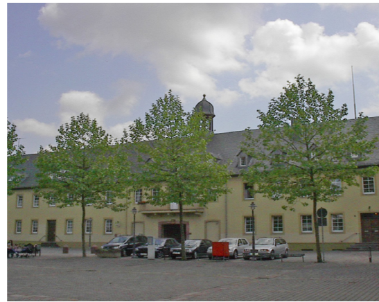
Ansicht Dienstgebäude aus nördlicher Richtung (Stand 2020)
